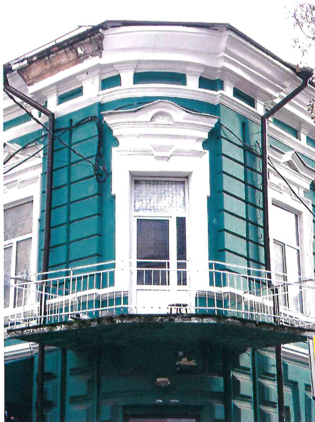
3. Балкон угловой северо-западной раскреповки.
