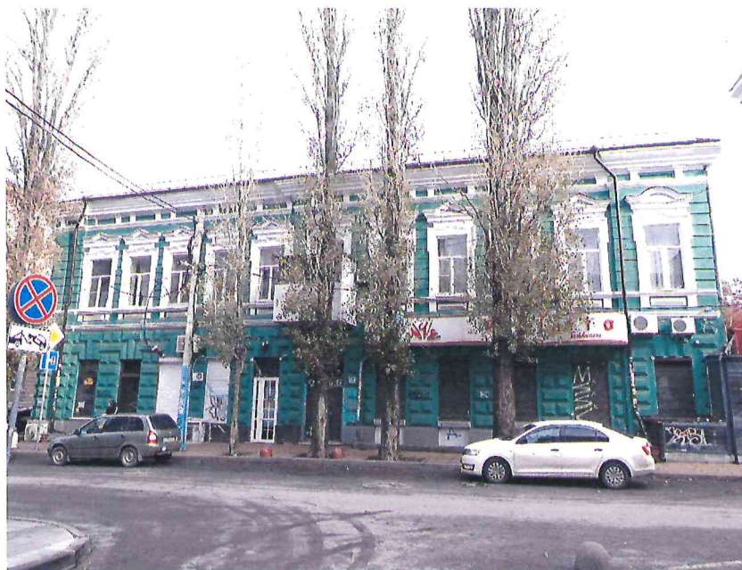
2. Общий вид западного фасада Объекта.
