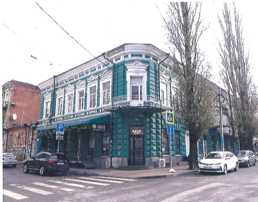
1. Общий вид Объекта с северо-запада.
